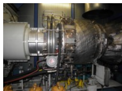
Plynová turbína TAURUS 60 v teplárni Radvaň
